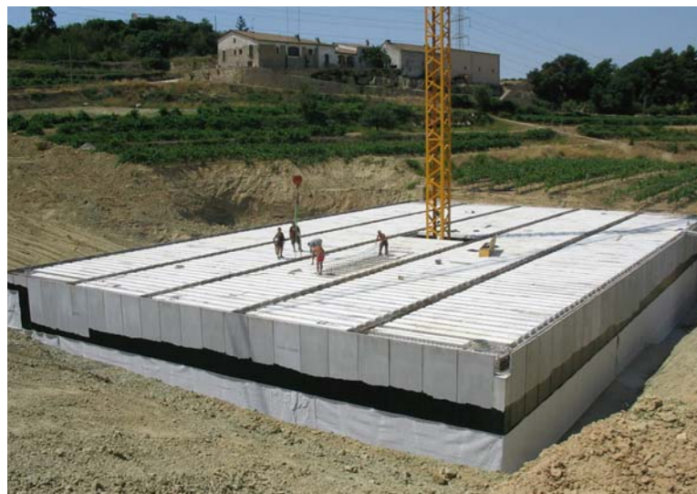
Ampliació de Cava, després totalment soterrada, amb sobre-càrrega de 2.000 Kgs.
