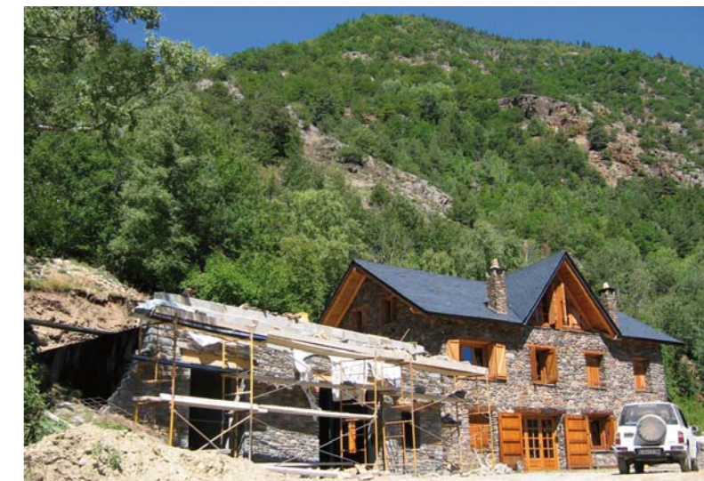
Borda d'Alta Muntanya, Pallars Sobirà. Garatge fet amb posterioritat a la borda ja existent. Després, damunt l'espai soterrat, s'hi va plantar un jardí.
